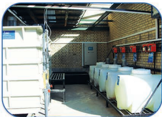
سیستم خنثی سازی پساب برای پساب های نیکل ، کروم و سیانور با امکان بازیافت آب به چرخه آبکاری با ظرفیت ۱۵ متر مکعب در روز
